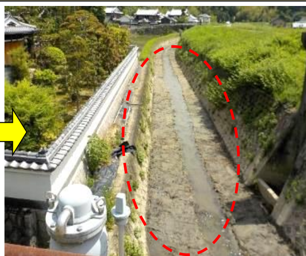
土砂を撤去して河川の流れを確保！
