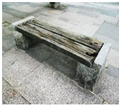
木製施設が腐っている
