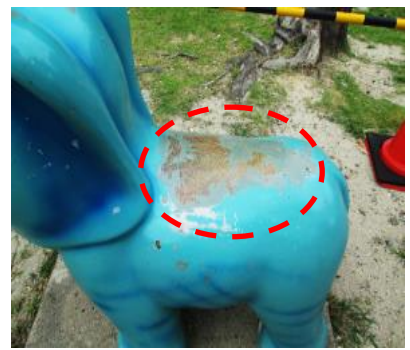
遊具の塗装が錆びている
