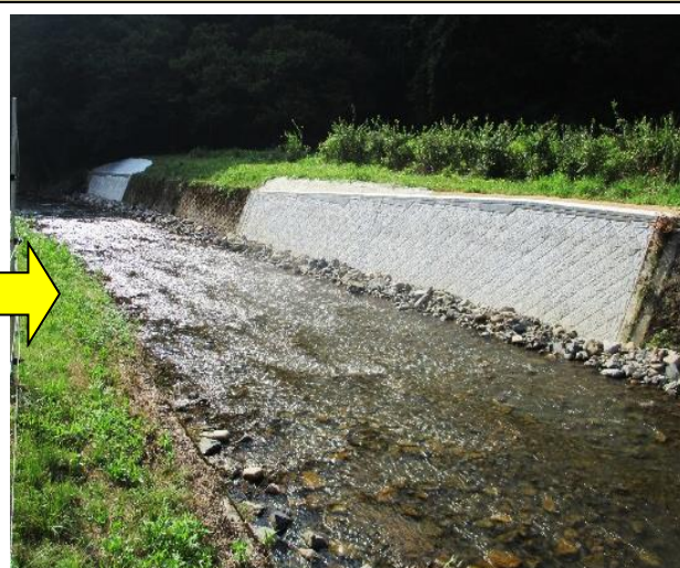
コンクリートブロックで改良！
