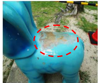
遊具の塗装が剥がれている
