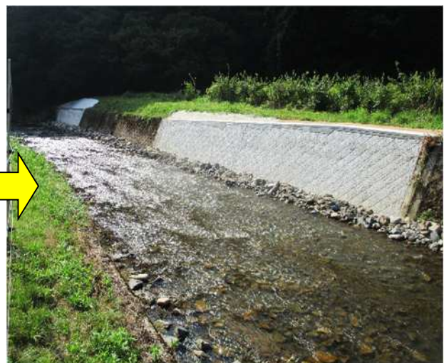
コンクリートブロックで更新！
