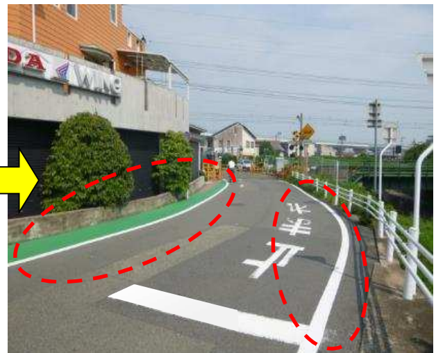
カラー舗装と区画線で歩行空間を明示！
