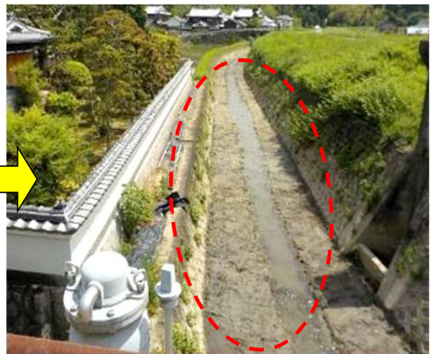
土砂を撤去して河川の流れを確保！
