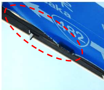
標識板が変形している
