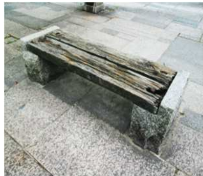
木製施設が腐っている
