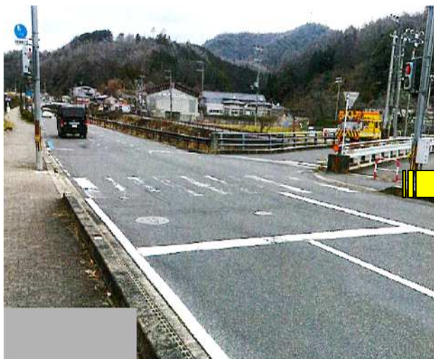
摩耗した道路標示を補修して視認性を改善
