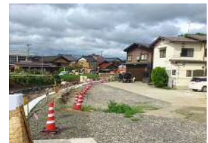
管理用道路整備予定箇所
