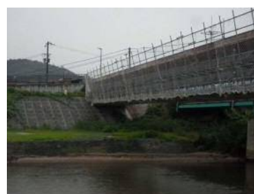
広瀬橋側歩道橋架設工事
