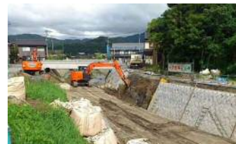
河川改修工事実施状況
