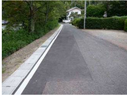
丹後:間人大宮線(京丹後市大宮町河辺) 側溝改良 実施区分:実施
