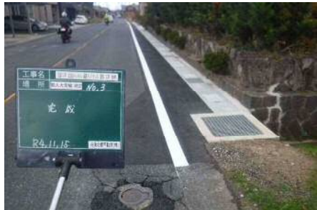
丹後:間人大宮線(京丹後市大宮町河辺) 側溝改良 実施区分:実施
