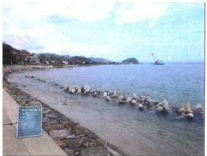
港湾局: 日置港(宮津市字日置) 消波ブロック設置 実施区分: 実施
