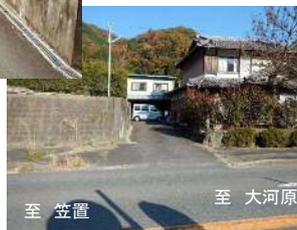
町道から国道への進入時、両側に擁壁と垣根があるが、国道163号への合流地点においては視距は確保されていてカーブミラーも設置されている。
