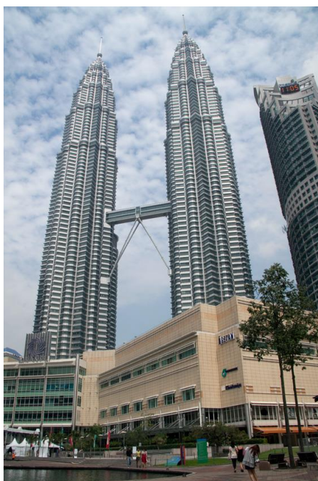
ペトロナス・ツインタワーの外観
