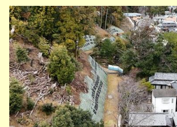
松室 (急傾斜地崩壊対策) 【京都市】
