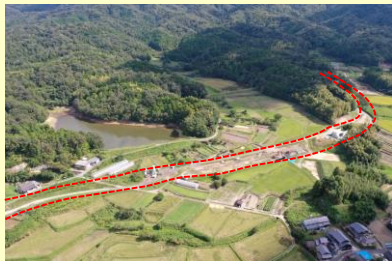
国道312号 (大宮峰山インター線) 【京丹後市】
