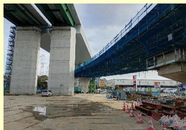
山城総合運動公園城陽線 (城陽橋) 【城陽市】
