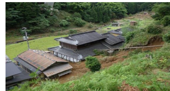
山腹斜面の崩壊(舞鶴市)
