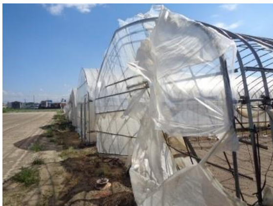
パイプハウスの被災(久御山町)
