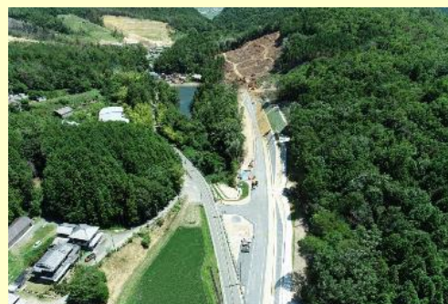
国道423号 法貴バイパス(亀岡市)
