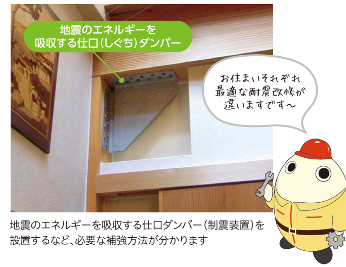
地震のエネルギーを吸収する仕口ダンパー(制震装置)を設置するなど、必要な補強方法がわかります
