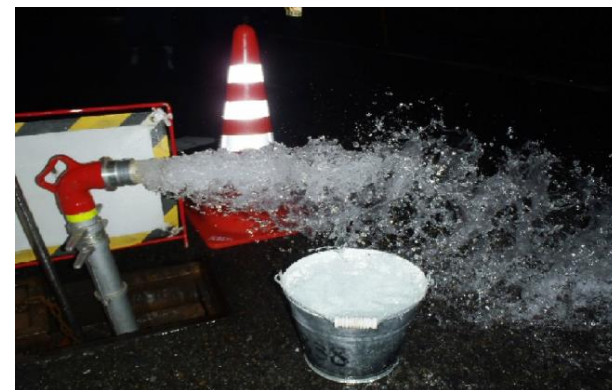
配水管洗浄作業の様子(京都市上下水道局HPから引用) http://www.city.kyoto.lg.jp/suido/page/0000200139.html
