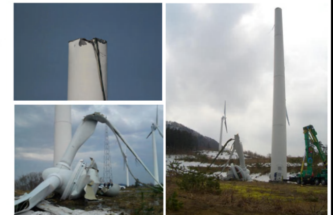
写真1-1 ナセル落下とタワーの破断状況
