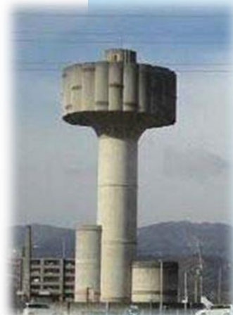
向日市 配水塔
