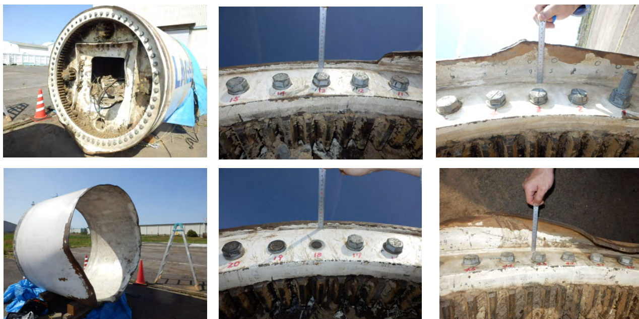
写真2-1 タワーとナセル側の破断状態
