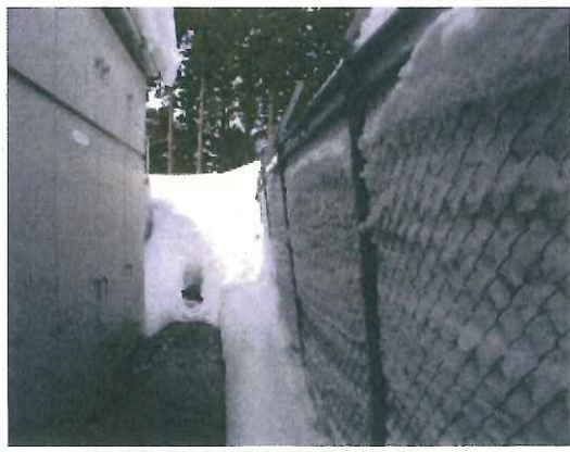
開閉所周辺積雪状況
