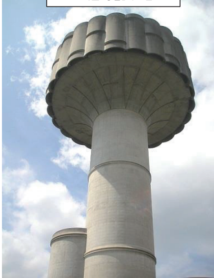
上植野配水塔
