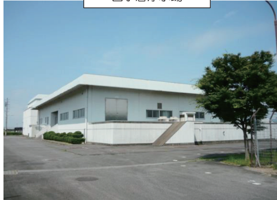
西小倉浄水場
