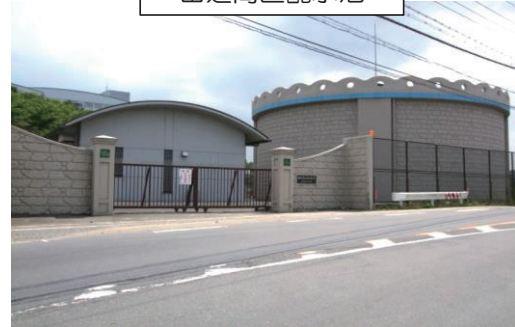
田辺高区配水池
