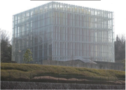
華の塔配水池
