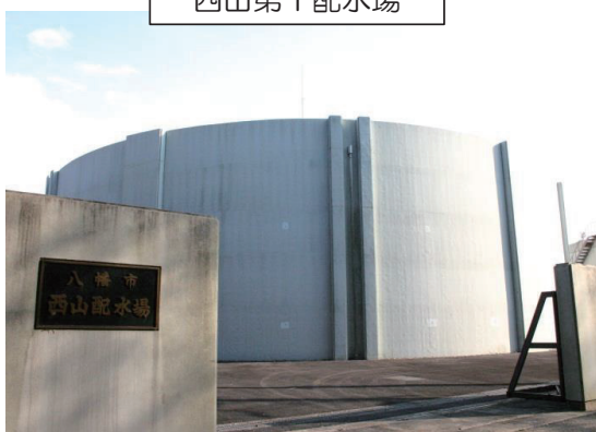
西山第1配水場
