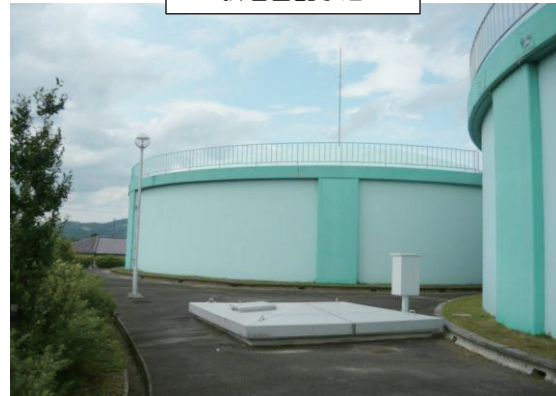
折居台配水池
