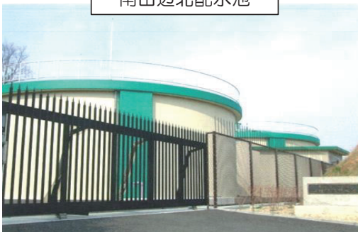
南田辺北配水池
