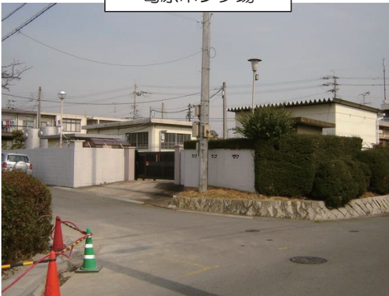
葛原ポンプ場
