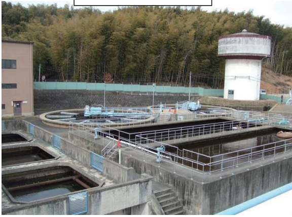
物集女西浄水場
