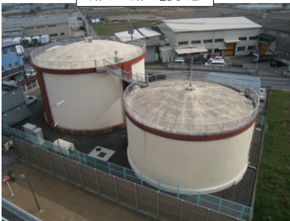
第3・第4配水池
