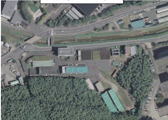
美濃山浄水場
