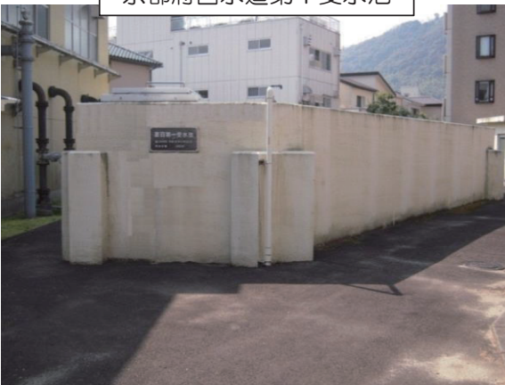
京都府営水道第1受水池
