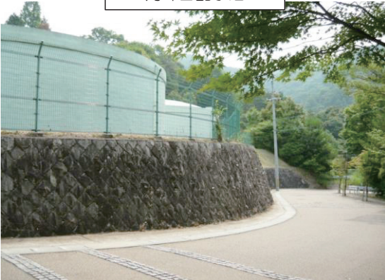
高峰山配水池
