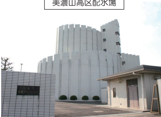
美濃山高区配水場
