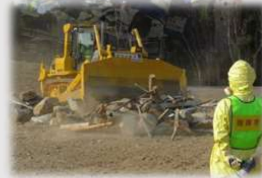
<がれき撤去訓練>
