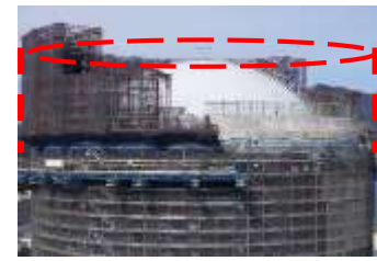
<外部遮蔽壁頂部の撤去> 2017.7~
