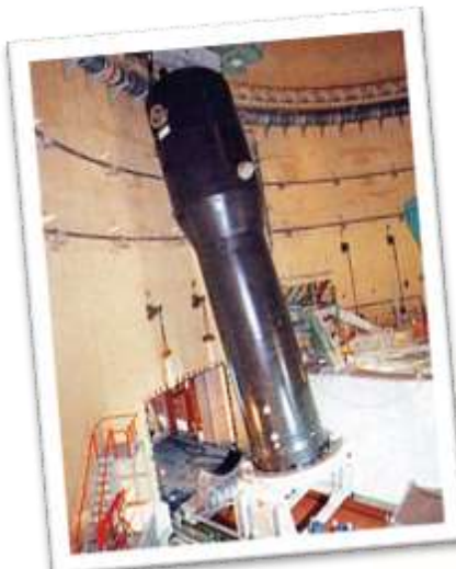
蒸気発生器の取替え
