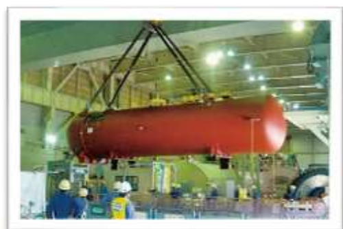
高圧給水加熱器の取替え
