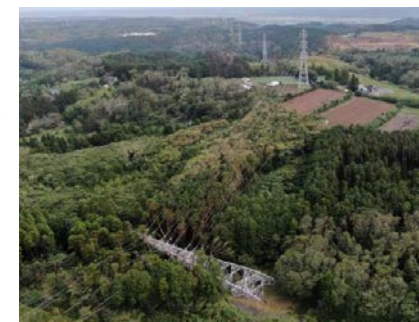
鉄塔設備の倒壊（君津市）
