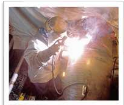
配管の取替え
