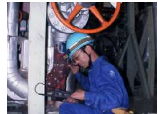
配管の厚み点検
