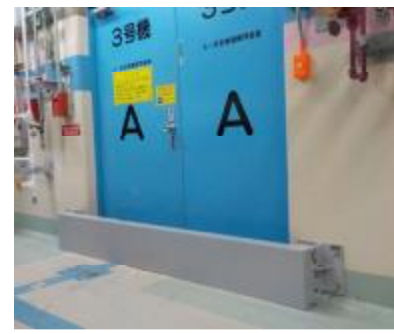
扉への堰の設置
