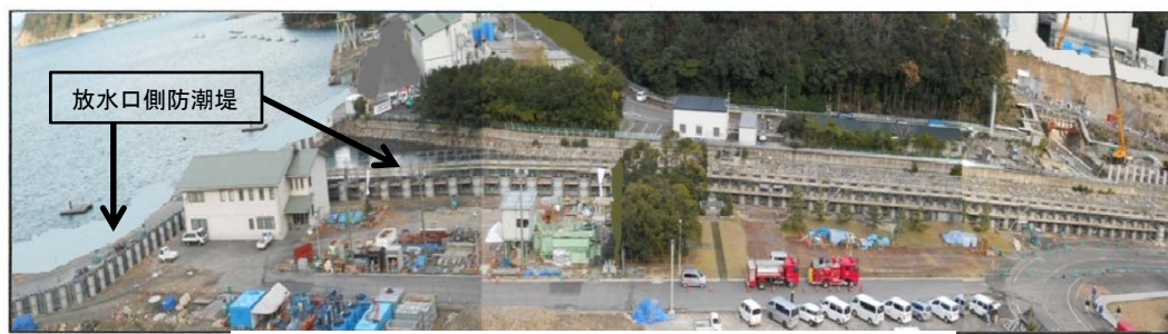
放水口側防潮堤
