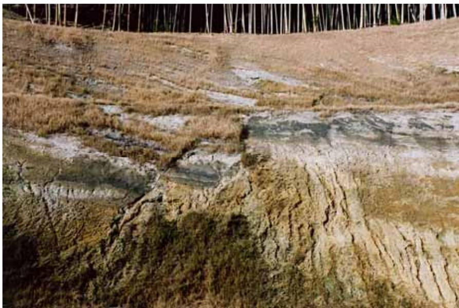
写真 - 4 切土法面に露出する正断層[撮影位置は図 - 6 に記載]
