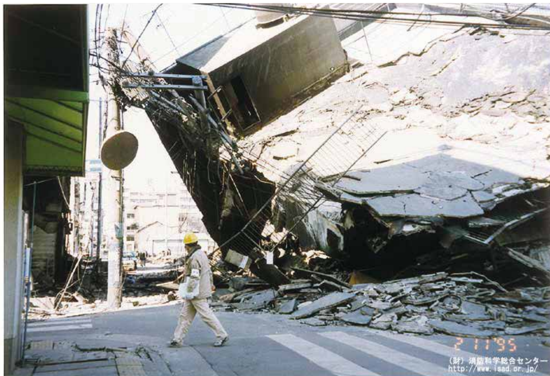
住家被害と道路閉塞（神戸市長田区・須磨区） 写真提供（一財）消防科学総合センター
