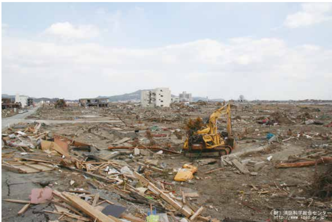
津波と津波火災による市街地被害（岩手県山田町） 写真提供（一財）消防科学総合センター
