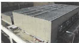
海水ポンプエリアの竜巻飛来物防護対策設備(設置後)
