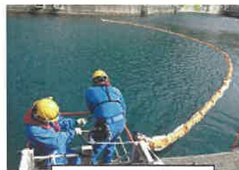
シルトフェンス設置
