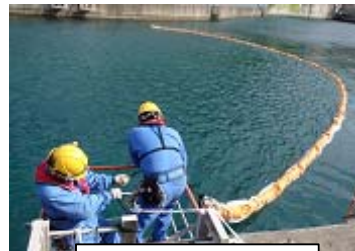
シルトフェンス設置
