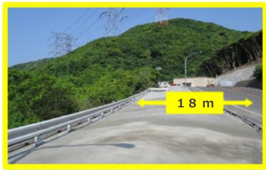
防火帯の工事状況（例）
