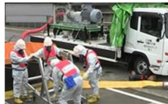
<可搬式代替低圧注水ポンプの設置訓練>
