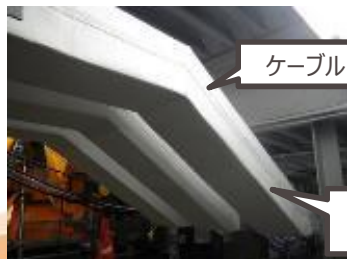
トレイ内へ自動消火装置 (ハロン式)を設置
