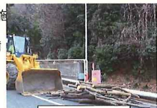
がれき撤去訓練
