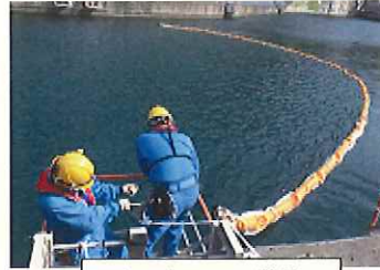
シルトフェンス設置
