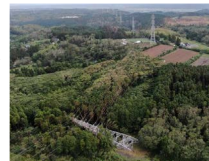
鉄塔設備の倒壊（君津市）
