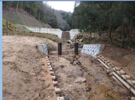
流木の撤去及び捕捉施設の設置(実施後)
