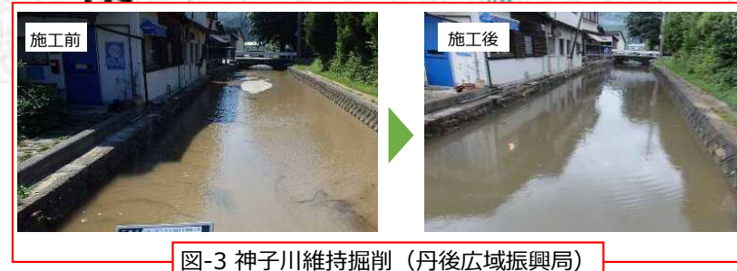
図-3 神子川維持掘削（丹後広域振興局）
