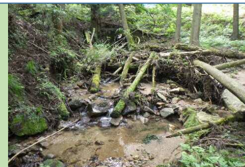
危険木の撤去(実施前)
