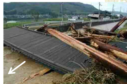
平成16(2004)年台風23号による被害 『浸水家屋 798戸、浸水面積 52ha』
