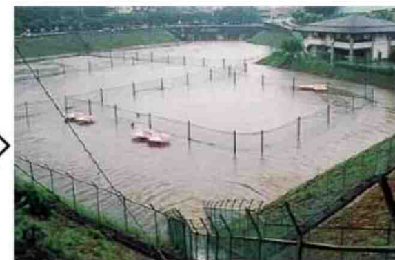
雨水貯留施設の整備
