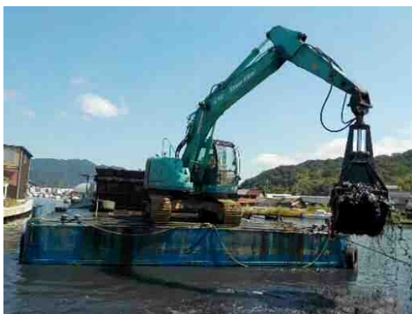
堆積土砂撤去
