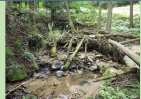
危険木の撤去（実施前）
