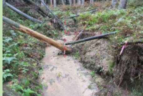
流木の撤去及び捕捉施設の設置（実施前）
