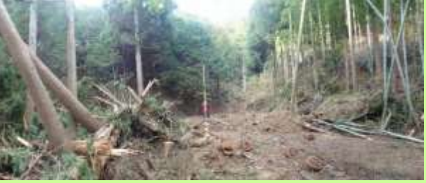
治山ダム工箇所
