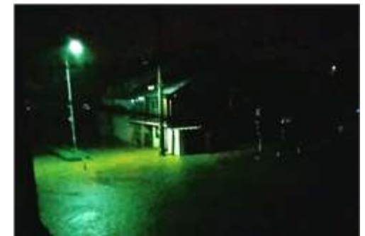
松ヶ崎第2排水区（竜宮） 平成29年台風21号
