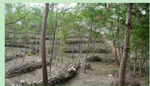
過密林の伐採後に土留工を設置
