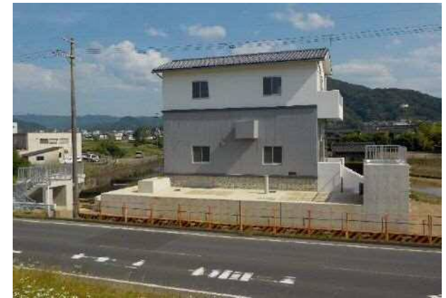
現在(土木・建築工事了)
