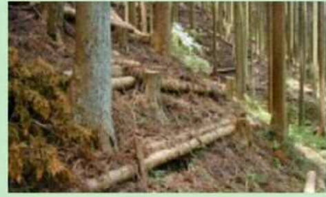
伐倒木を利用した土留工の設置例
