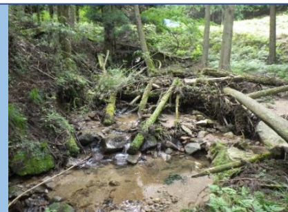
危険木の撤去(実施前)
