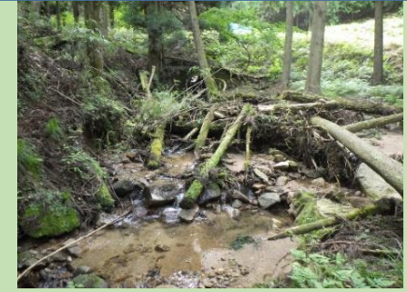
危険木の撤去(実施前)
