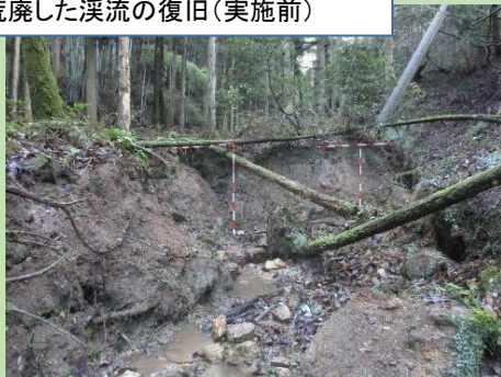
荒廃した溪流の復旧(実施前)
