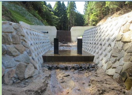
流木の撤去及び捕捉施設の設置(実施後)
