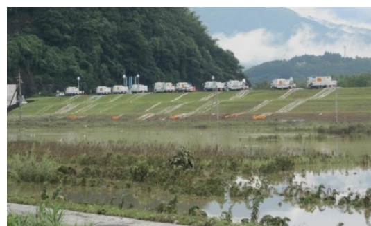
近畿地方整備局の排水ポンプ車稼働状況 (H30年7月豪雨・福知山市荒河排水機場)
