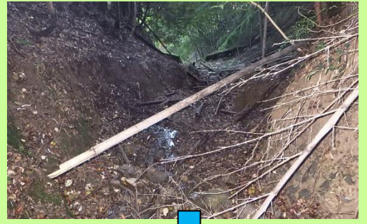
流木・土砂の撤去（実施前）
