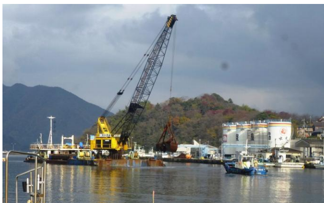
河口部掘削状況
