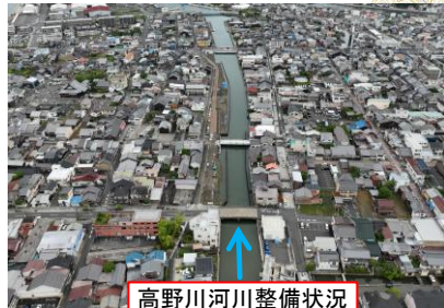
高野川河川整備状況
