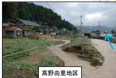
高野由里地区 平成16年台風23号による被害 『浸水家屋 798戸、浸水面積 52ha』
