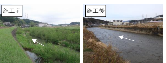
図-1 維持掘削・河道内樹木伐採
