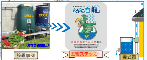
図-3 マイクロ呑龍(各戸雨水貯留施設)
