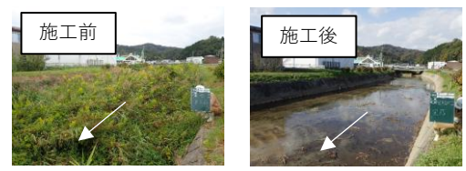
図-1 維持掘削・河道内樹木伐採
