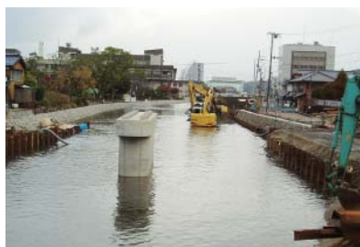
大手川の改修工事
