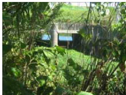
図 1-14 小川 合同樋門(木津川合流点)
