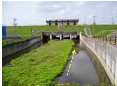
図 1-9 防賀川 上津屋樋門
