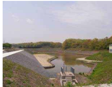
煤谷川防災調節池
