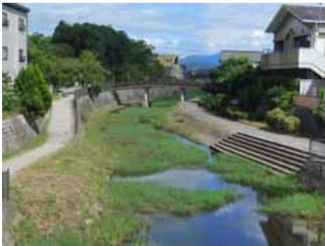
大谷川（安居橋周辺）
