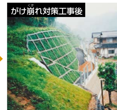
工事によって安定したがけ
