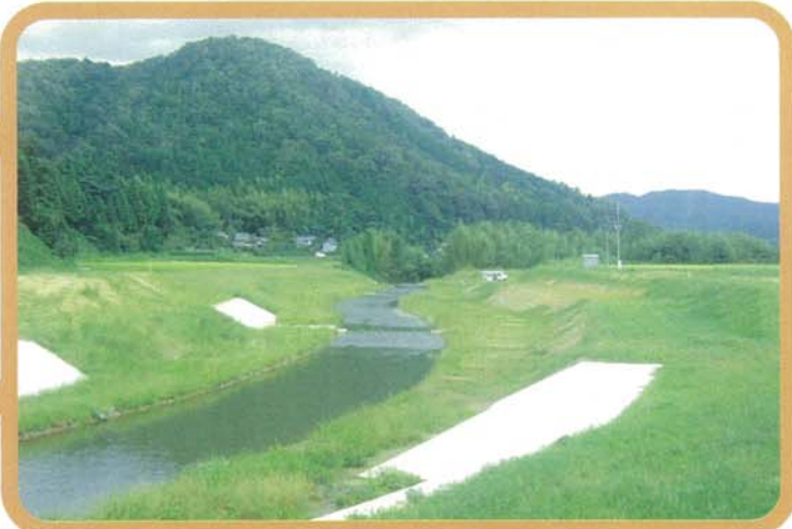
犀川農業基盤整備事業関連河川改修事業
