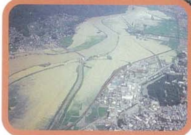
桂川浸水状況（平成元年9月）
