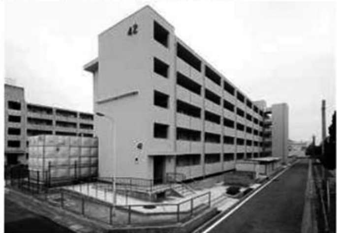
エレベーター棟の増築、スロープの設置等
