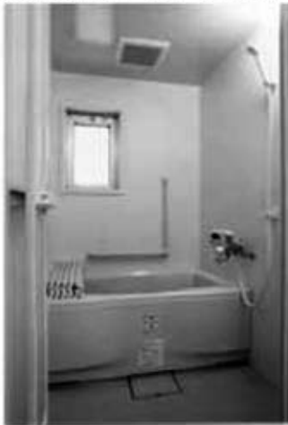
手すりを設けた浴室
