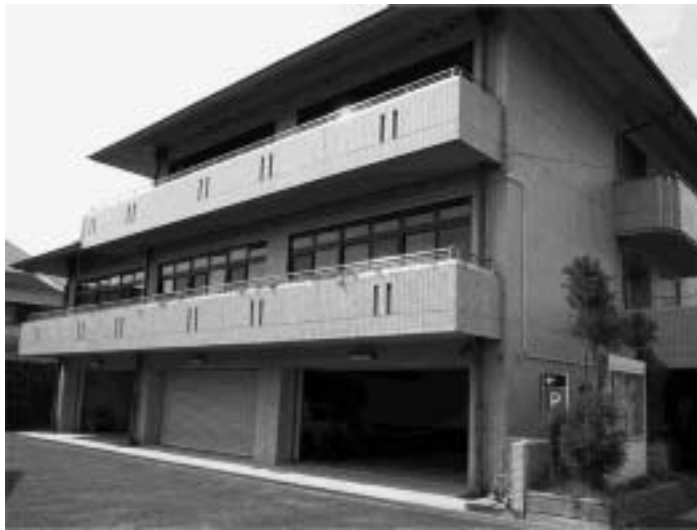
【写真3.2.1】乙訓農改センター物件の外観
