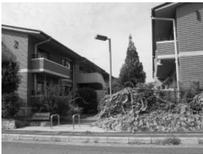
【写真3.8.1】北芝公舎物件の外観
