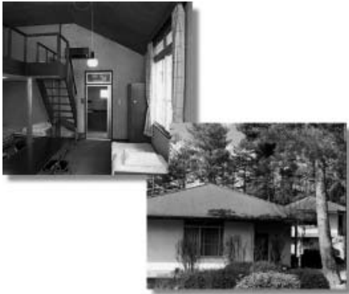
【写真18.2】ゼミナールハウス (左上：宿泊室内部) (右下：ユニットハウス外観)
