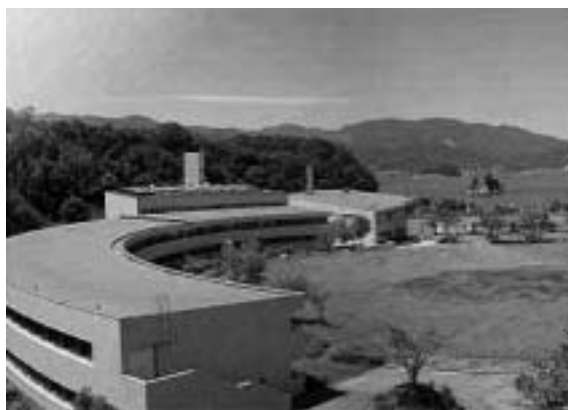
【写真9.2.2】青少年海洋センター 宿泊棟
